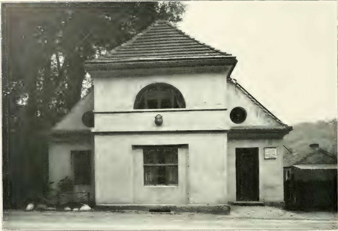
Chausseehaus an der Straße von Berlin nach Freienwalde 1803.
